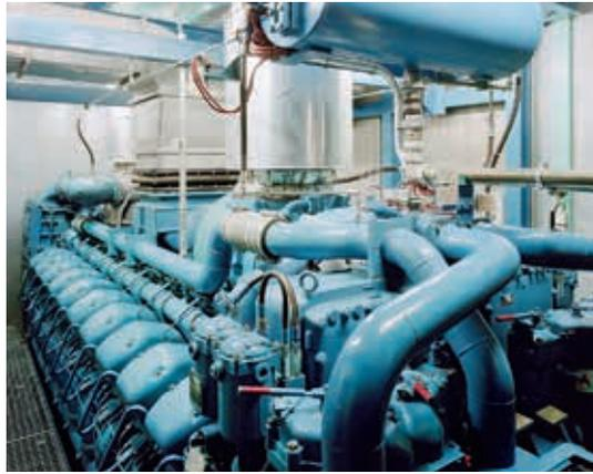
Eines von vier 20-Zylinder-Notstromdieselaggregaten, die in wenigen Sekunden im Notfall Vollbetrieb aufnehmen können
