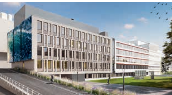
Auf der linken Seite entsteht ein freundlicher Erweiterungsbau mit knapp 3.000 Quadratmetern Nettonutzfläche.
